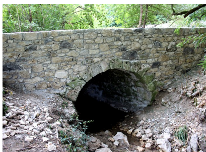
Restauration du pont romain reliant Sigoulès-et-Flaugeac à Mescoules
