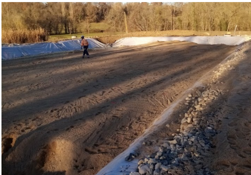
■ Pose de feutre géotextile avant plantation des roseaux
