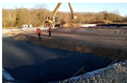
■ Travaux sur la STEP
