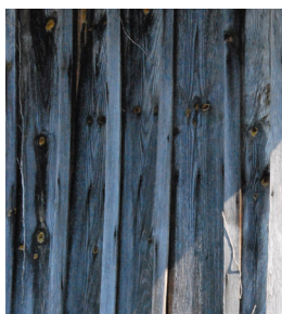
Le Fleix - Bardage à couvre-joint
