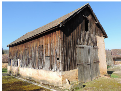
Le Buisson de Cadouin - Séchoir hybride en portiques bois, bardage bois et mur de moellons au Nord
