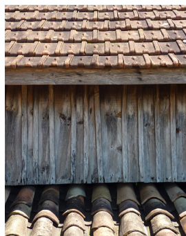
Le Fleix - Tuile plate mécanique losangée et canal pour l'appenti
