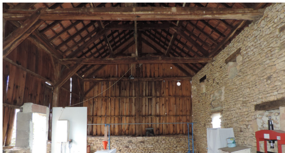
Le Buisson de Cadouin - Séchoir hybride en portiques bois, bardage bois et mur de moellons au Nord
